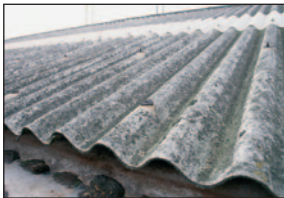
© INRS Toiture en amiante ciment
