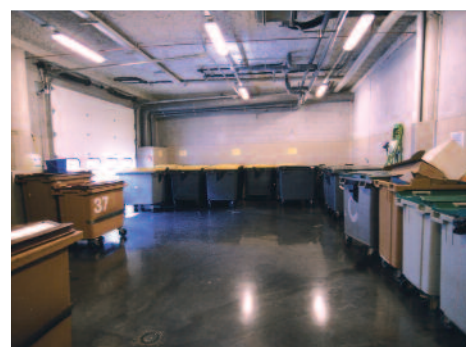
Salle d'entreposage des déchets.
