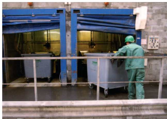
Lavage automatique des GRV.
